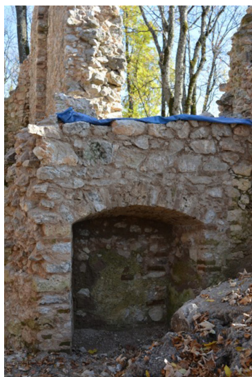
Úsek prepojenia prejazdu hlavného paláca, s mohutným nárožím a zaslepeným oknom staršej stavebnej fázy
