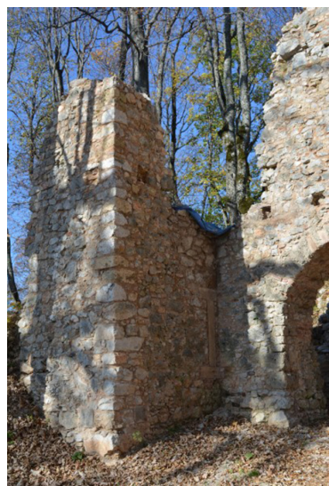
Úsek prepojenia prejazdu hlavného paláca, s mohutným nárožím a zaslepeným oknom staršej stavebnej fázy
