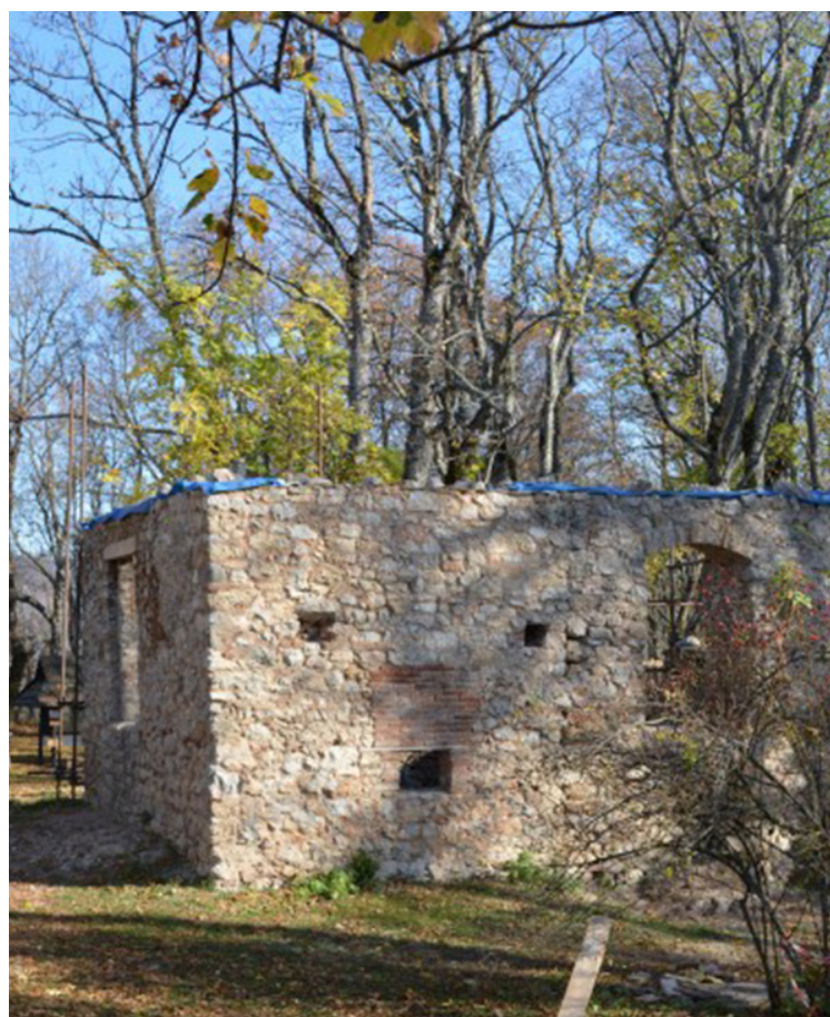
3. Dom veliteľa V tejto sezóne sa realizovalo doplnenie bočnej (južnej), a zadnej (západnej) fasády, ako príprava na plánované zastrešenie stavby. Konkrétne sa jedná o domurovanie a konzerváciu až po úroveň pomúrnic.
