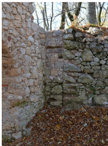
Konzervácia styku dvoch starších stavebných fáz paláca sprej prejazdovej prístavby.
