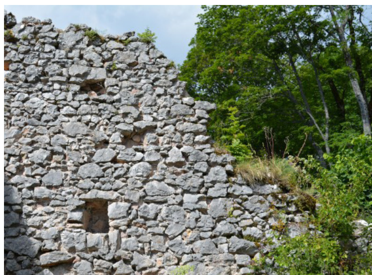
2. Koháryho palác Doplnenie muriva a plošné prešpárovanie vnútornej južnej steny Koháryho paláca
