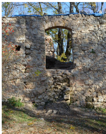
Na strane západnej bol doplnený základný vstup z exteriéru na prvé poschodie (vonkajším dreveným schodiskom na vysunutých konzolách).
