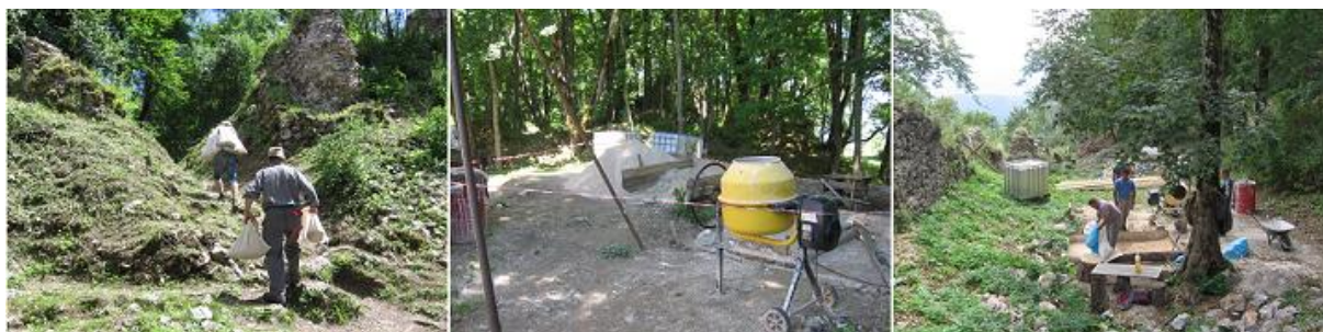
Prenášanie kameniva od vstupnej brány k stavebnému zázemiu, stavebné zázemie I. a II.
