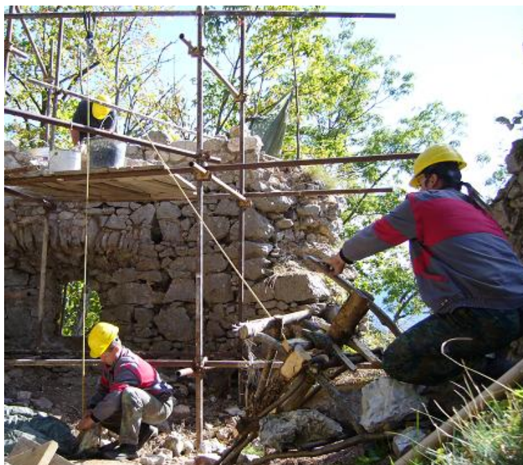
Kľčovrátok – tohtoročný vynález na uľahčenie odstraňovania koreňov, najskôr statický – jeho použitie potrebovalo strom v blízkosti, neskôr aj mobilný, ktorý bolo možné použiť aj na zdvíhanie ťažkých bremien:
